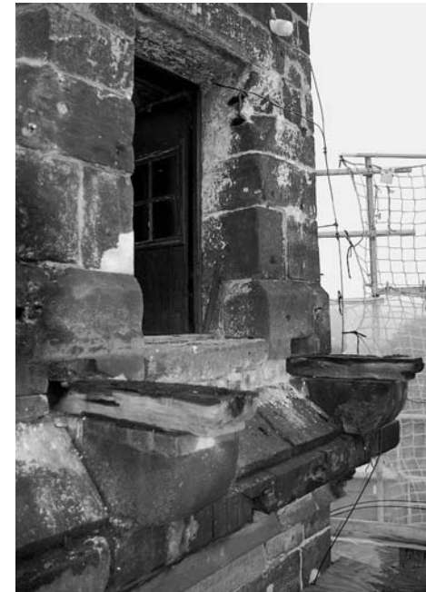
Die letzten Reste des alten Balkons
